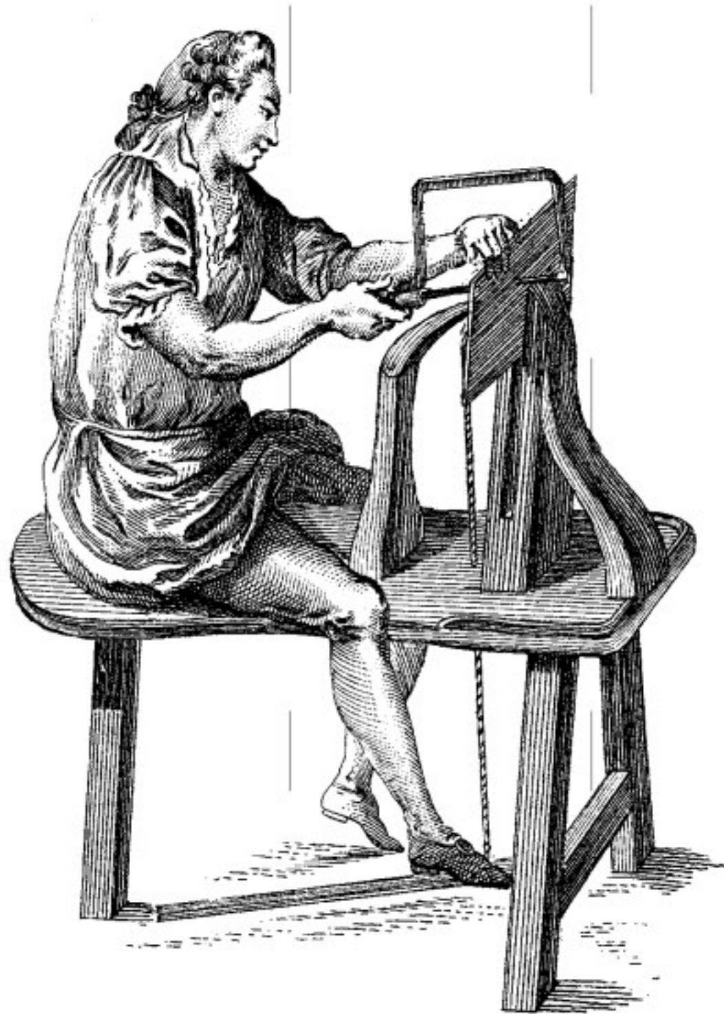
Die Abbildung aus einer frühen französischen Enzyklopädie um 1774 zeigt einen „Ebenisten“ bei der Arbeit mit der Laubsäge
