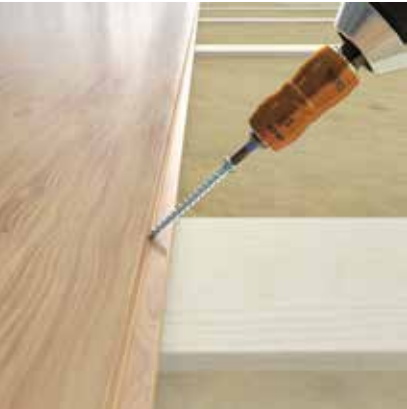
Fixierung von Dielenbelag
