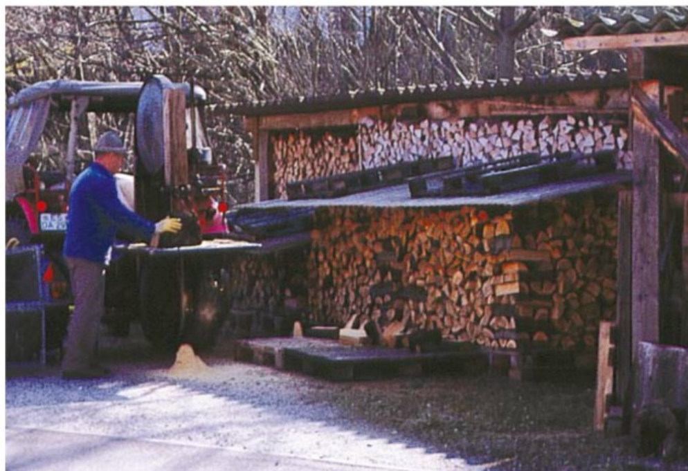
Ein einfacher Schuppen für die Lufttrocknung von Holzscheiten
